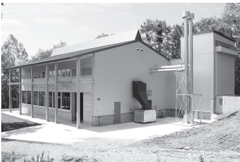
運転を停止している木質チップボイラー（館岩地域高杖原地内）
